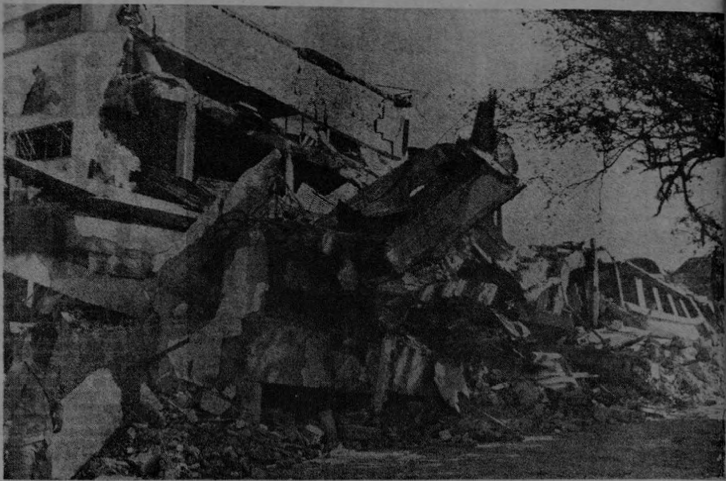
COLEGIO RELIGIOSO. — El edificio del Colegio Divina Pastora situado al este de la ciudad, cerca del Estadio Somoza, quedó en las condiciones que se aprecian en la gráfica. Varias religiosas murieron atrapadas y hasta la fecha no se han podido rescatar todos los cuerpos. La foto fue tomada desde la 3ª Calle S.O. y el edificio se encuentra en una de los sectores más afectados por el terremoto. (J. G. Chan).
