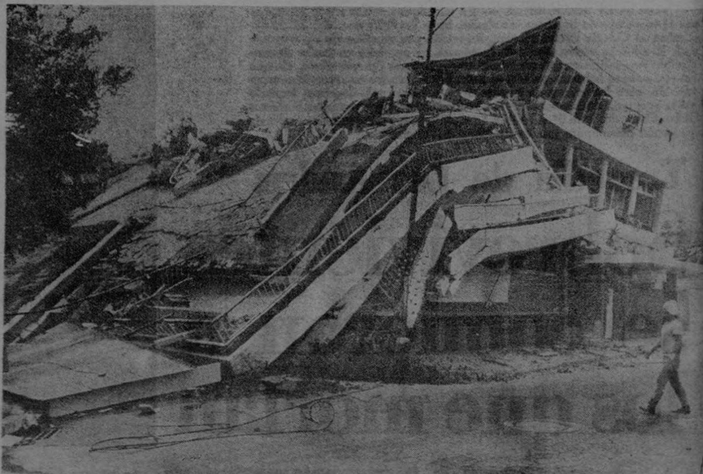
EDIFICIO DE APARTAMENTOS. — Cerca de treinta personas murieron atrapadas en este edificio de apartamentos según nos informaron. Antiguamente estuvo ocupado por las oficinas del Seguro Social. Se puede apreciar a varias personas que aprovechan la forma en que quedó el edificio para subir a él en busca de enseres utilizables. (J. G. Chan).
